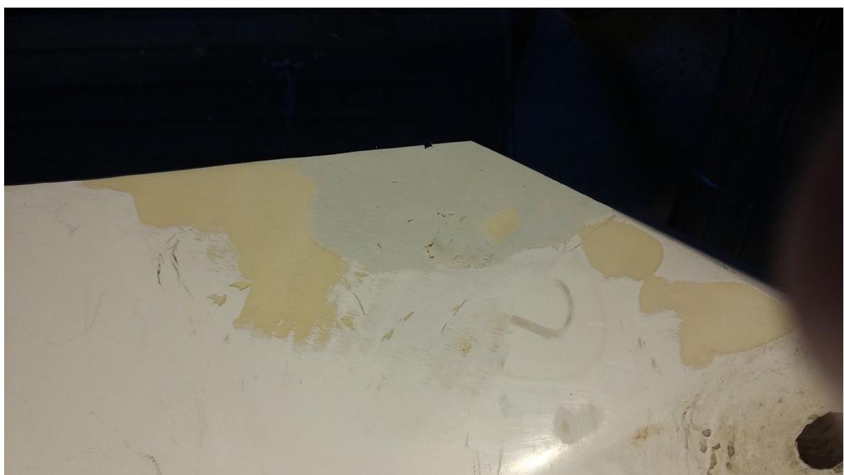
La structure est solide, On peut maintenant passer au mastic de finition
